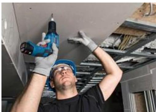
Этот легкий и компактный шуруповерт длиной всего 207 мм обеспечивает комфорт даже при работе в труднодоступных местах, а также когда инструмент приходится держать над головой.
