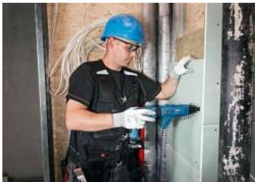
GSR 10,8 V-EC TE Professional также имеет встроенную светодиодную подсветку, рукоятку с мягкой накладкой, индикатор уровня заряда. К нему прилагаются различные принадлежности, например магазинная насадка MA 55 Professional для лент с шурупами Bosch.
